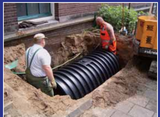
Infiltratietunnel voor het infiltreren van grote hoeveelheden regenwater
