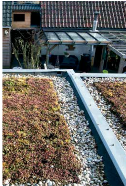
Groen dak Hovenhierstraat
